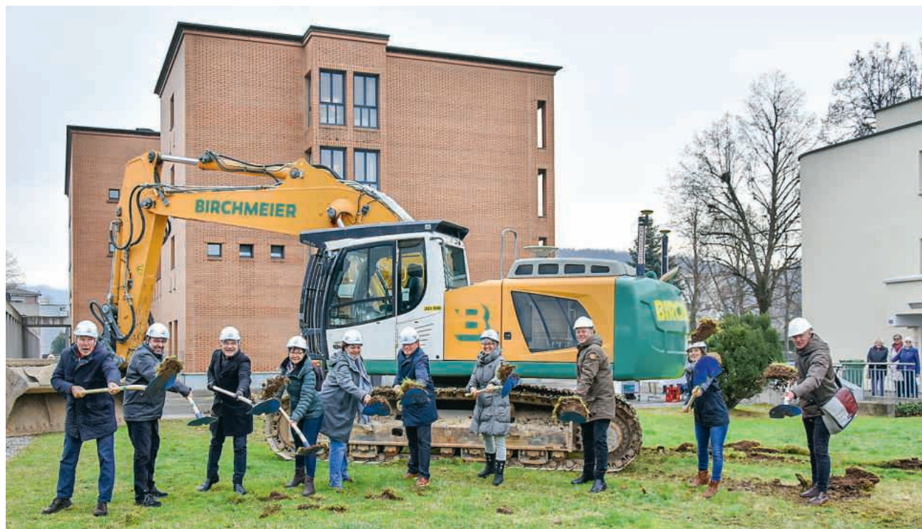
Stiftungsrat, Architekten und Geschäftsleitung vollzogen den Spatenstich – beobachtet von Bewohnenden
